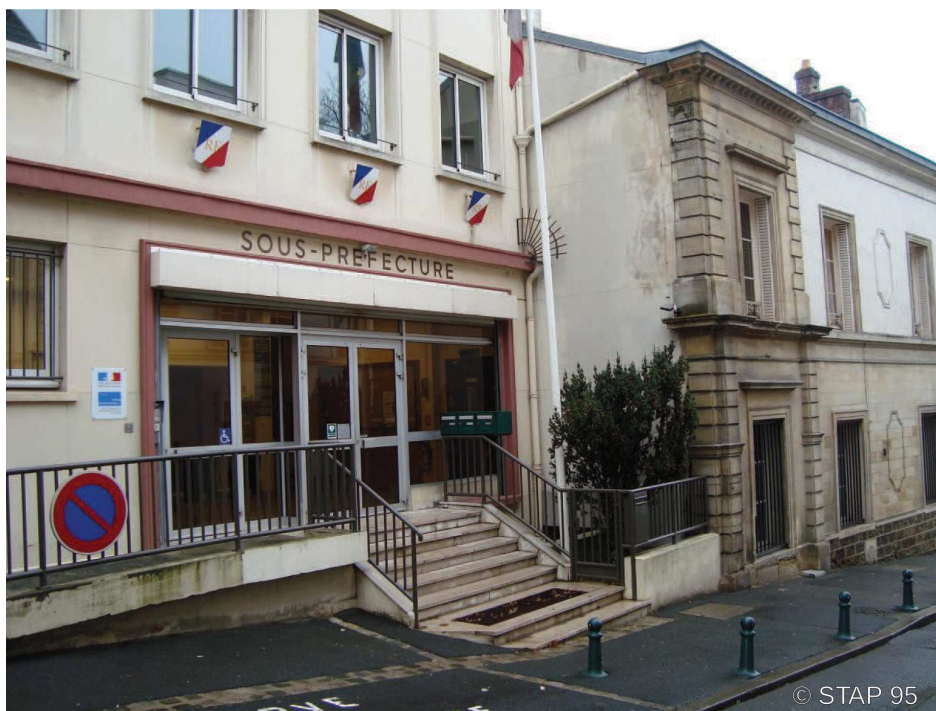
cliché du bâtiment – STAP 95 au 3ème étage
